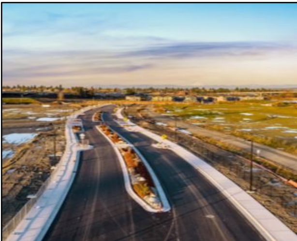
Vista norte del Sitio del Everett Tire Fire
