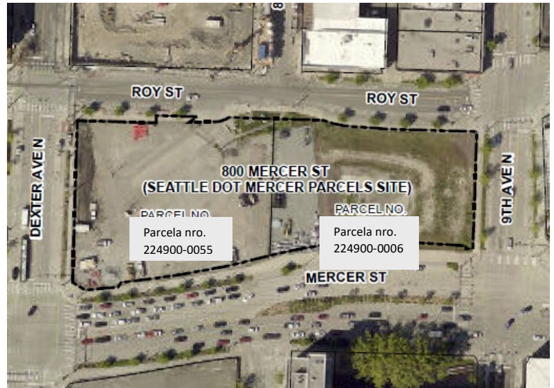
Figura 1. Vista aérea del sitio Seattle DOT Mercer Parcels en el vecindario South Lake Union de Seattle. Las líneas punteadas negras son el límite de la propiedad.
