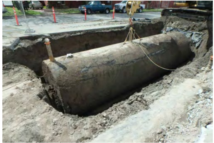
從站點拆除的地下儲罐
