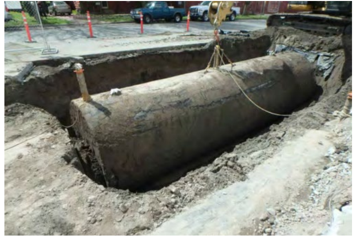
Tanques subterráneos de almacenaje removidos del sitio
