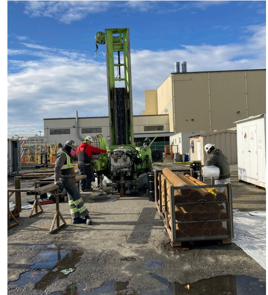
Khoan đất và lắp giếng, Tòa nhà C-29, Tháng 11 năm 2022
