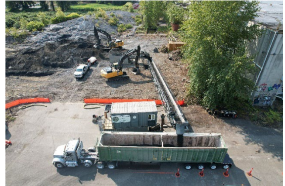
Progreso en la eliminación de pilas de escoria (2023)
