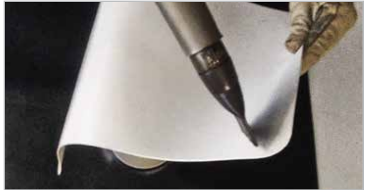
STEP 2A. Heat edge and stretch NR
