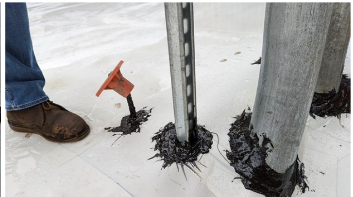
SV.02.03.B - Overview of pipe penetration
