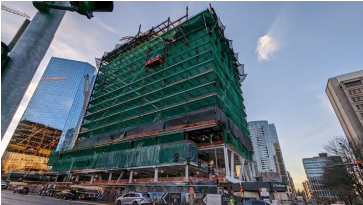
SV.04.01.A - Overview of Tower
