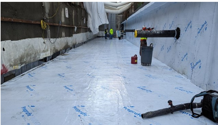
SV.04.02.A - Overview of Preprufe installation progress
