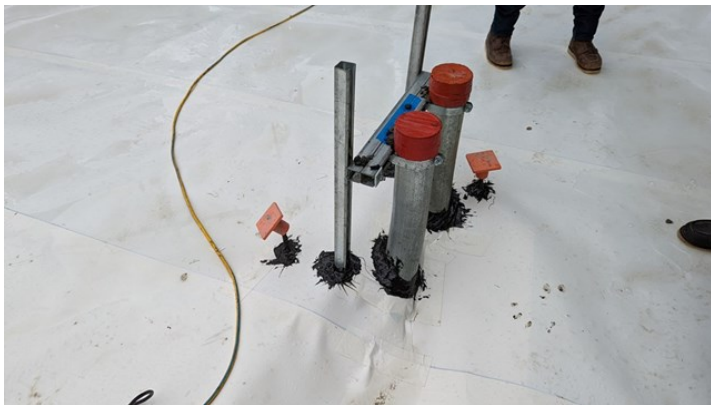
SV.02.03.A - Overview of pipe penetration
