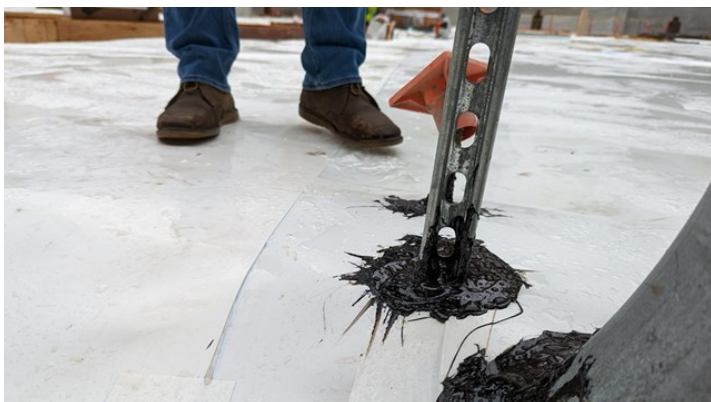
SV.02.03.C - Overview of pipe penetration
