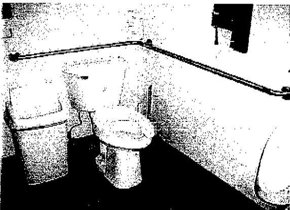
Photo #17: Tenant bathroom
