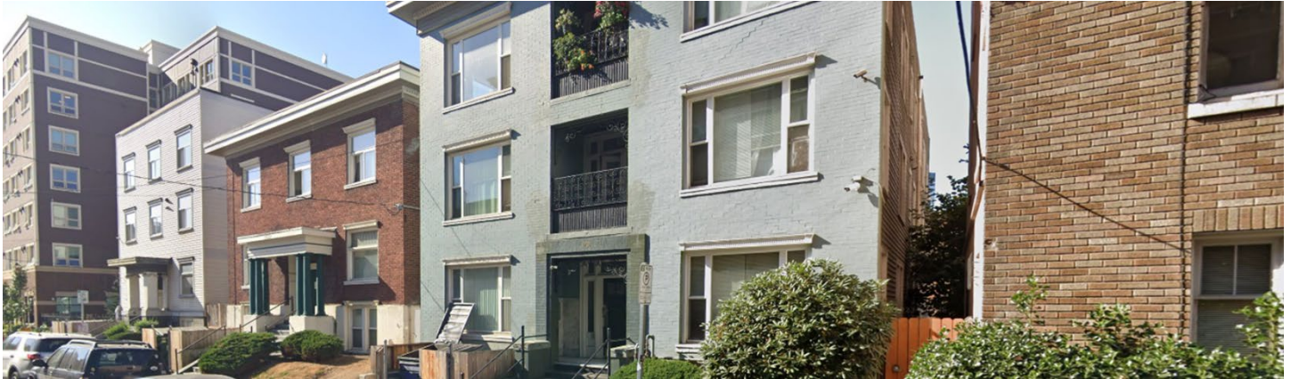
Stewart House 清理现场 (图片来源: google地图)
