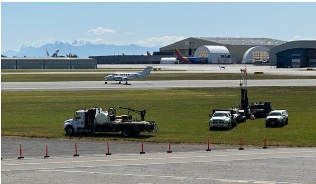
Instalación de pozo de monitoreo en el sitio, 2024
