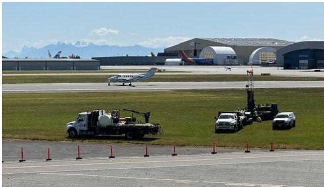
Lắp đặt giếng quan trắc tại khu vực năm 2024
