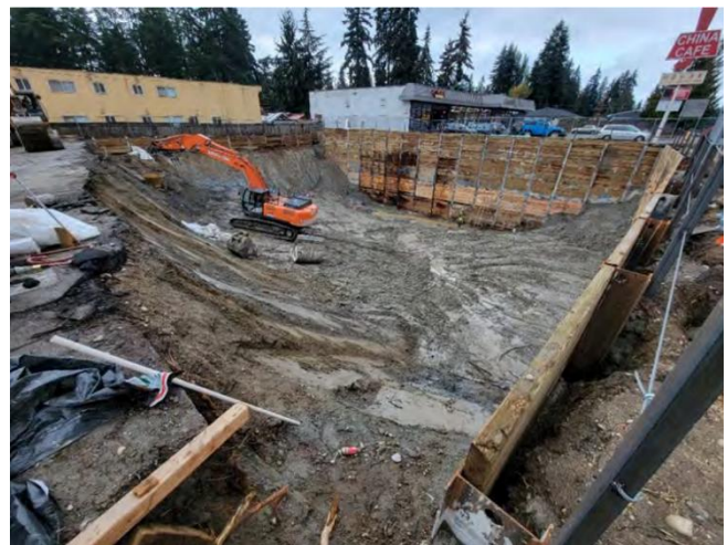
Imagen 1 Muestra la excavación que se llevó a cabo durante la acción provisional en 2022. Durante esta limpieza, se retiraron más de 15,000 toneladas de tierra.
