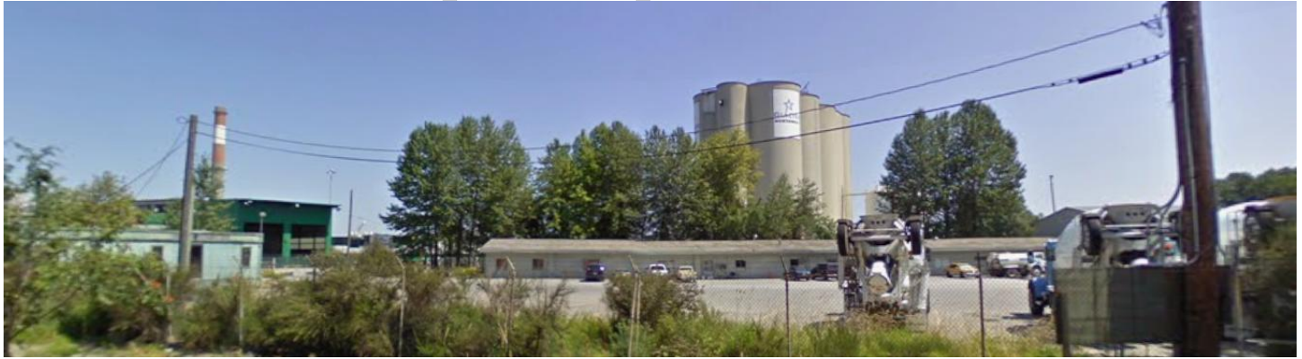
Vista del sitio desde W Marginal Way SW.
