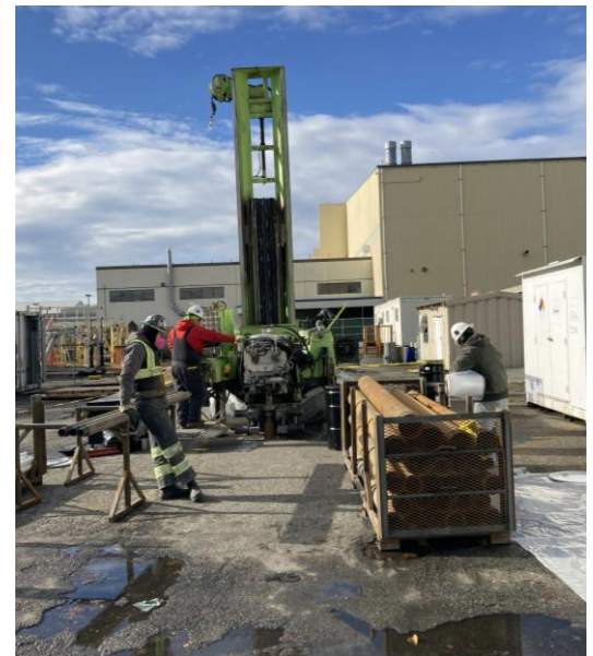
Imagen 2: perforaciones del suelo e instalación de pozos, edificio C-29, noviembre de 2022
