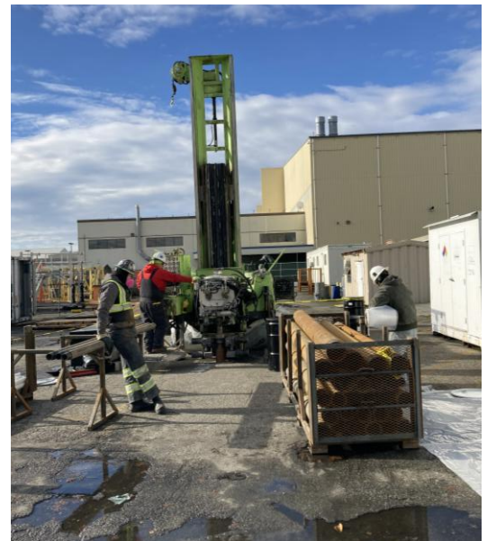
Зображення 2. Буріння ґрунту й облаштування свердловин, Будівля С-29, листопад 2022 р.
