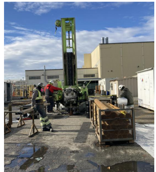
Изображение 2. Бурение грунта и обустройство скважины, здание С-29, ноябрь 2022 г.
