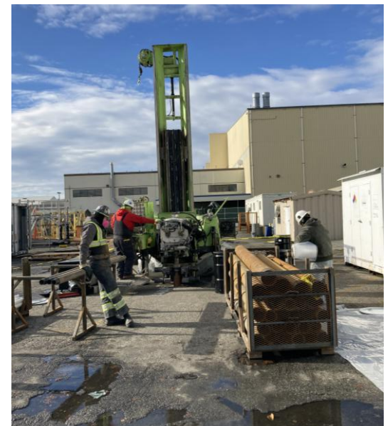
Hình 2: Khoan đất và lắp đặt giếng, Tòa nhà C-29, tháng 11 năm 2022
