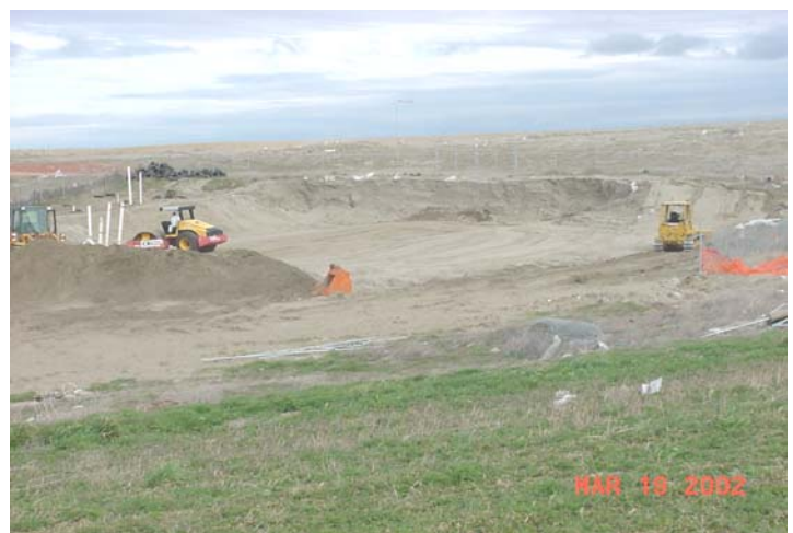
Después de Remover los Barriles de la Zona B
