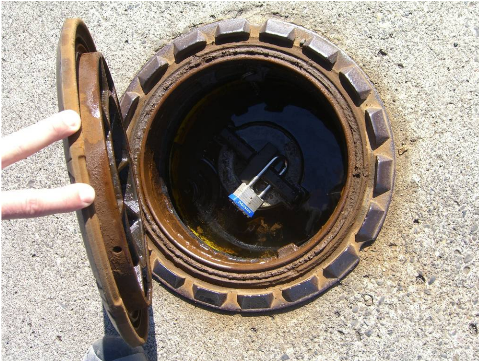
Photo 4: L&C Deli UST Fill
