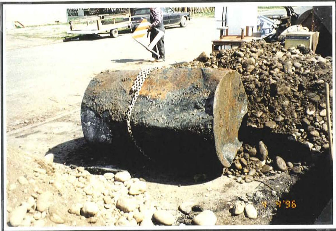
Photo 3. UST #1(note holes).
