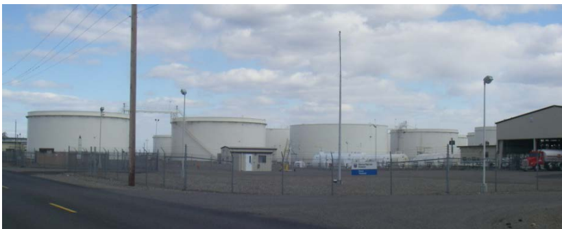
Sitio de la Terminal de Depósito de Combustible en Pasco de la Compañía Chevron Pipe Line
