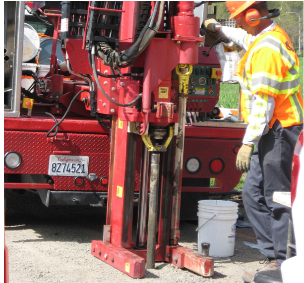
Taladrando por muestras de agua subterránea al noreste de Algona.
