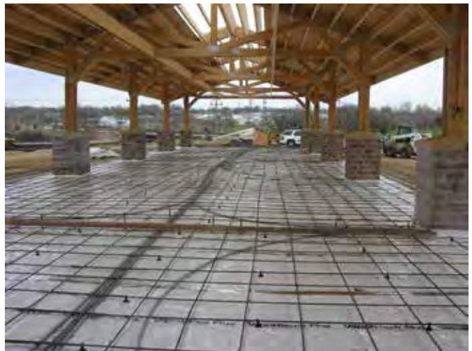
Under-Slab Vapor/Gas Retarder
