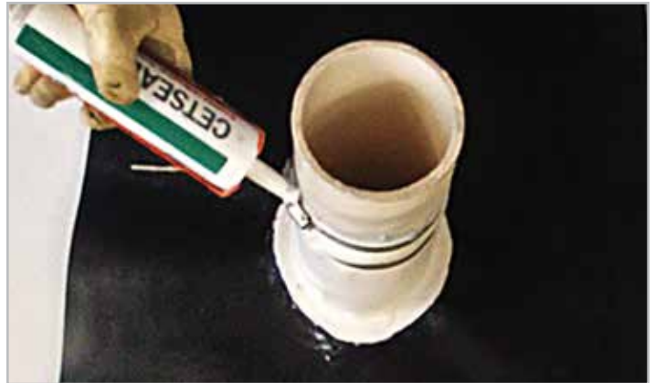
STEP 10. Install CETSEAL termination
