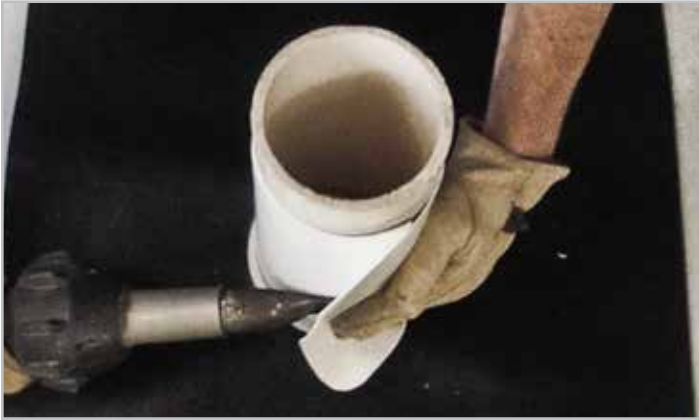
STEP 3. Tack weld NR
