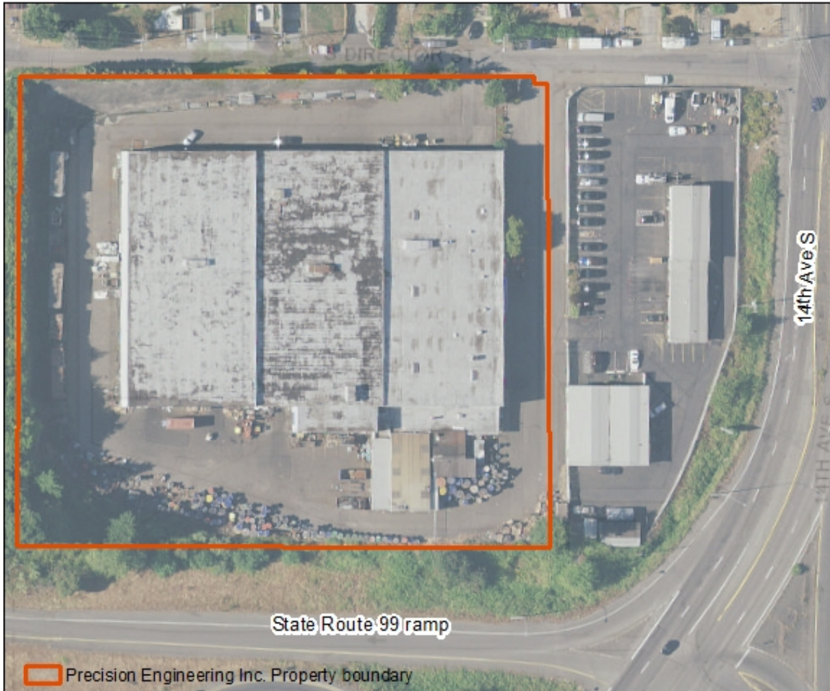
Vista aérea del sitio Precision Engineering Inc.
