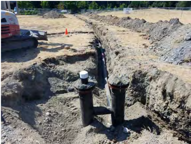
STA 3+86 LOOKING WEST
