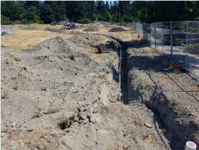
STA 1+00 LOOKING EAST
