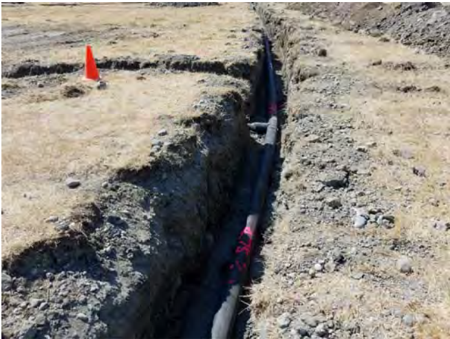
STA 3+70 LOOKING WEST
