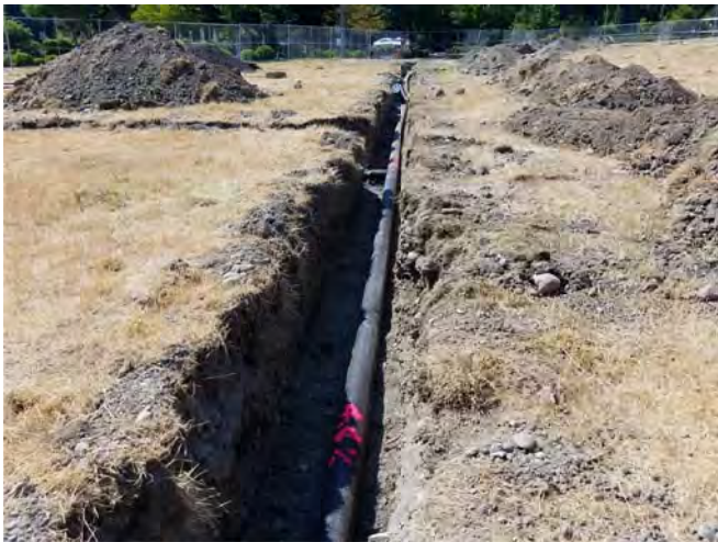
STA 3+10 LOOKING WEST
