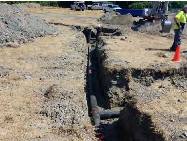
STA 3+45 LOOKING EAST
