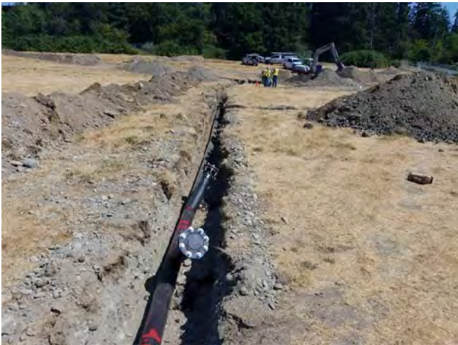
STA 2+40 LOOKING EAST
