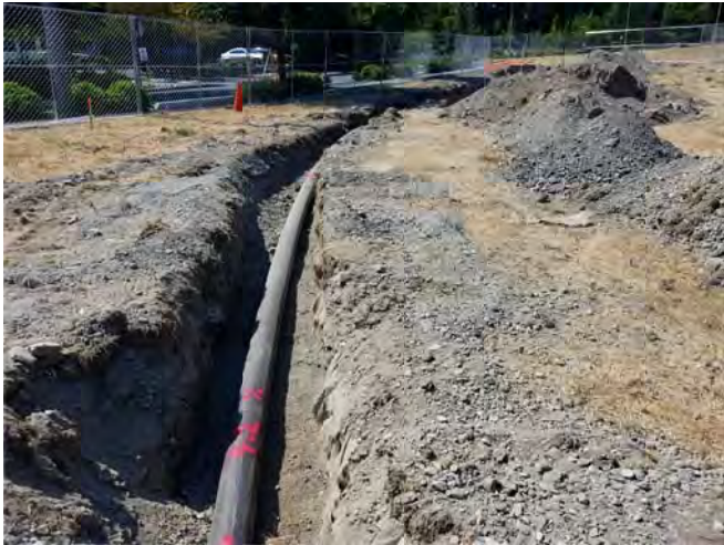
STA 1+90 LOOKING WEST
