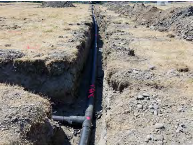
STA 3+55 LOOKING WEST
