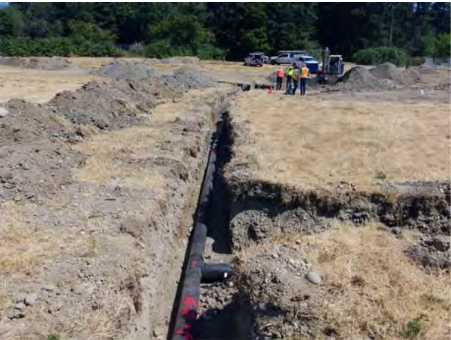
STA 2+75 LOOKING EAST
