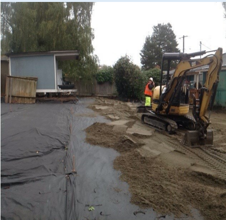
Figura 4: Rellenando con suelo limpio
