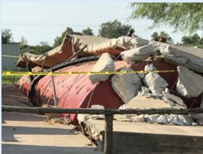
홍수가 발생하면서 부력으로 지하탱크가 지상으로 노출됨. 기후변화란 홍수다발 지역에 더 많은 극심한 홍수가 발생하거나, 홍수안전 지역에 홍수가 발생함을 뜻한다.
