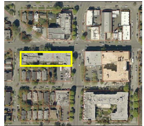
Imagen aérea de Stone Way Apartments..
