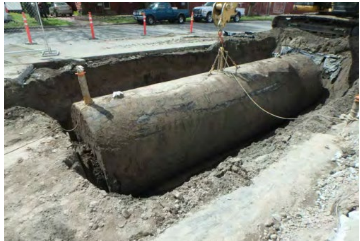
Tanques subterráneos de almacenaje removidos del sitio
