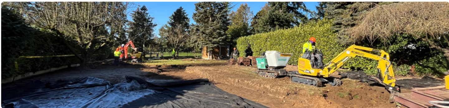
Thi công nhóm tẩy nhiễm năm 2022.
