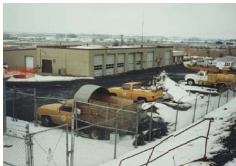
Instalación de Mantenimiento de la Ciudad de Moses Lake
