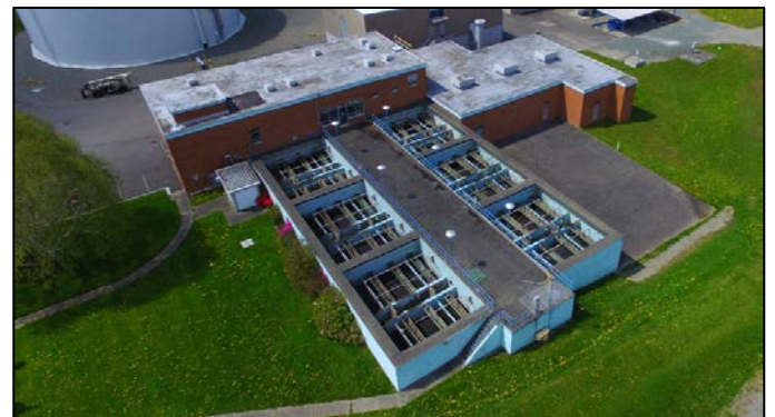
Cuenca de Filtración desmantelada
