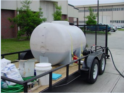
Comida para bacterias espera ser inyectada en el sitio Boeing Auburn.
