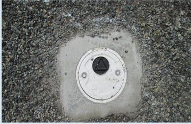
Figura 1. Un pozo de monitoreo en el sitio de Boeing Auburn. Boeing tomará muestras de los puntos de acceso al pozo de monitoreo para rastrear la concentración de TCE en el sitio a lo largo del tiempo.
