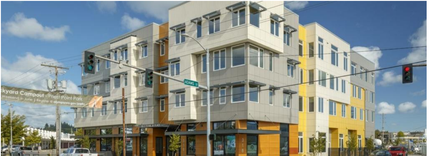
圖1. The Billy Frank Jr. Place, 曾經的清理站點提供了可負擔房屋。照片來源：瑟斯頓縣房屋管理處。
