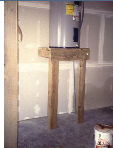
El propietario reemplazó un calentador de agua dañado por la inundación por otro más corto y lo elevó.
