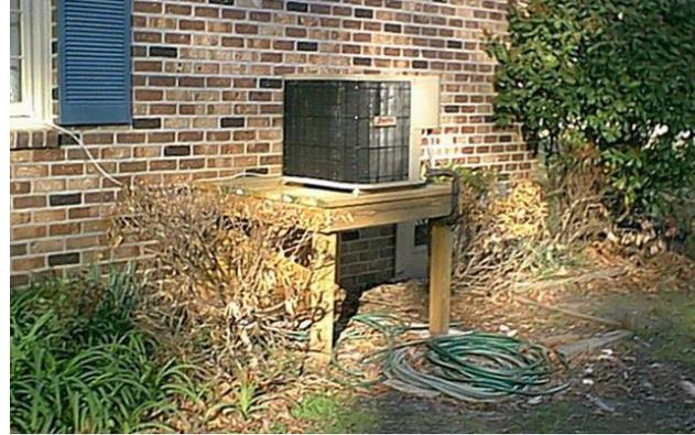
Después de que una inundación destruyera los servicios de calefacción, ventilación y aire acondicionado (*Heating, Ventilation, and Air Conditioning Systems, HVAC*) en el sótano de esta casa, el propietario elevó el compresor del aire acondicionado y reubicó la unidad central de calefacción y los conductos en el ático. Este proyecto también dio lugar a un un espacio de acceso a prueba de inundaciones.
