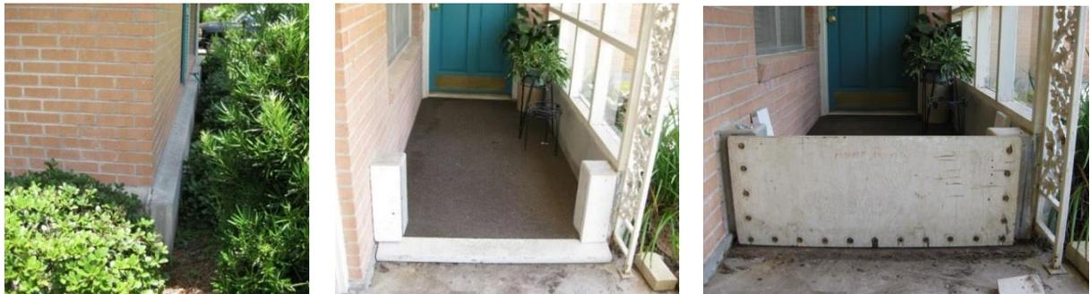
Esta casa fue impermeabilizada en seco por el propietario, con una pared de hormigón alrededor de la losa, un muro bajo en la entrada y un cierre desmontable que requiere de una hora de aviso para retirarse. La medida ha funcionado para las inundaciones del drenaje local desde que se construyó en la década de 1960. Se desbordó cuando un dique cercano falló durante una inundación mayor.
