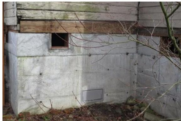
En la readaptación de este edificio de Bucoda, se colocaron rejillas de ventilación aisladas cerca del suelo que se abren automáticamente para dejar entrar el agua.
