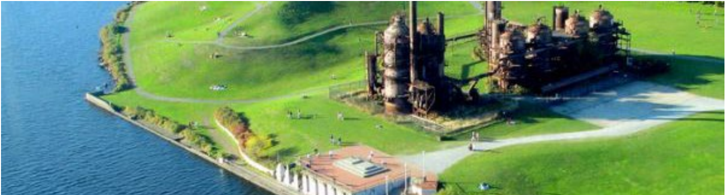
Sitio de Gas Works Park en la orilla norte del lago Unión
