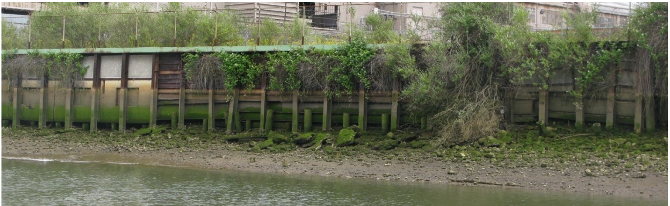
图3 Port of Seattle 场地北侧的木制屏蔽墙。
