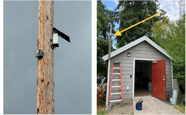
Un SensWA alzado en un poste de electricidad (izquierda) y en un edificio anexo (derecha).
