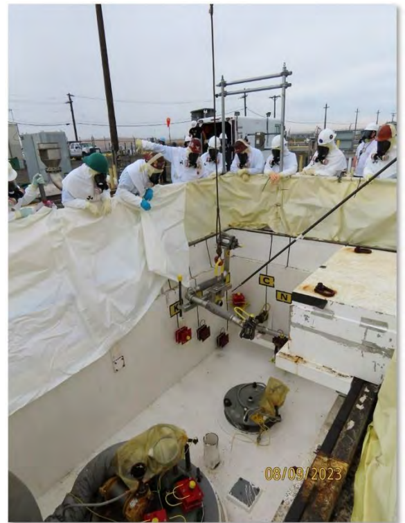
Trabajadores instalando línea de transferencia de residuos
