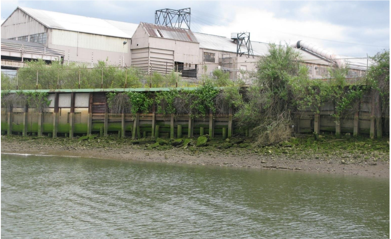
Vách ngăn gỗ của Port of Seattle ở phía bắc Địa Điểm.
