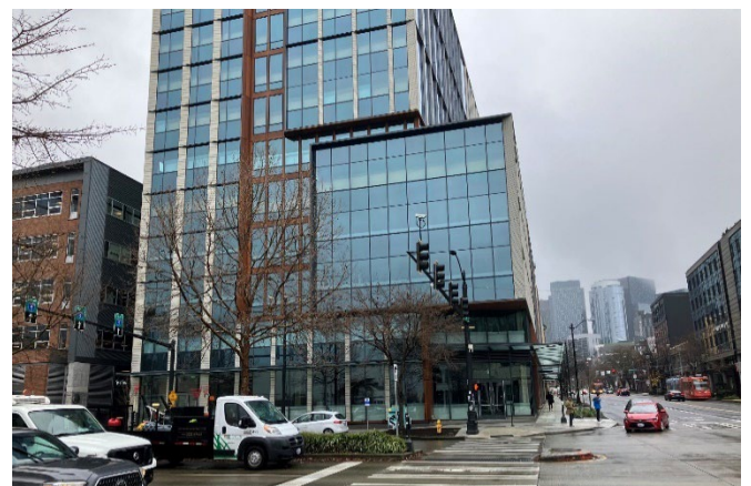
2023年2月Block 38 West地产上的新建建筑
